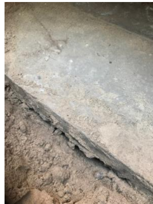
Tijdens de inspecties in november werd in beide gevallen een betonplaat (zogenaamde fundering op staal) aangetroffen.
